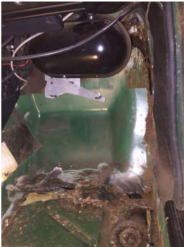
Höger sida fram, bara att sätta fart och börja lappa ihop
